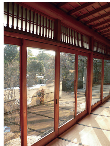
中棟入側廊下 （アメリカ製の硝子戸は歪みなく畳廊下を映す）
