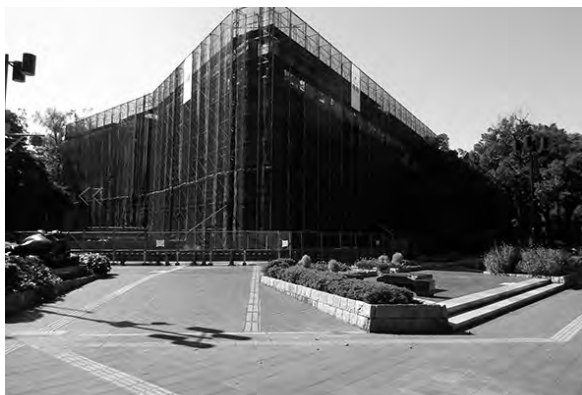
美術館正面（工事中）
